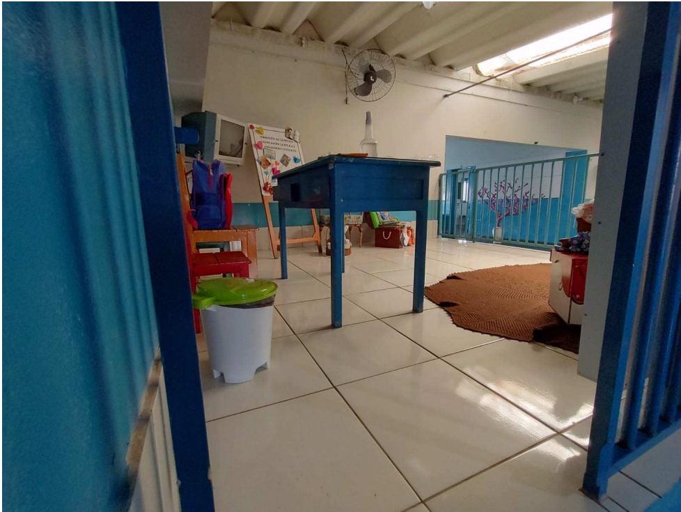
Foto 5 (Palco onde será colocado forro de gesso);
