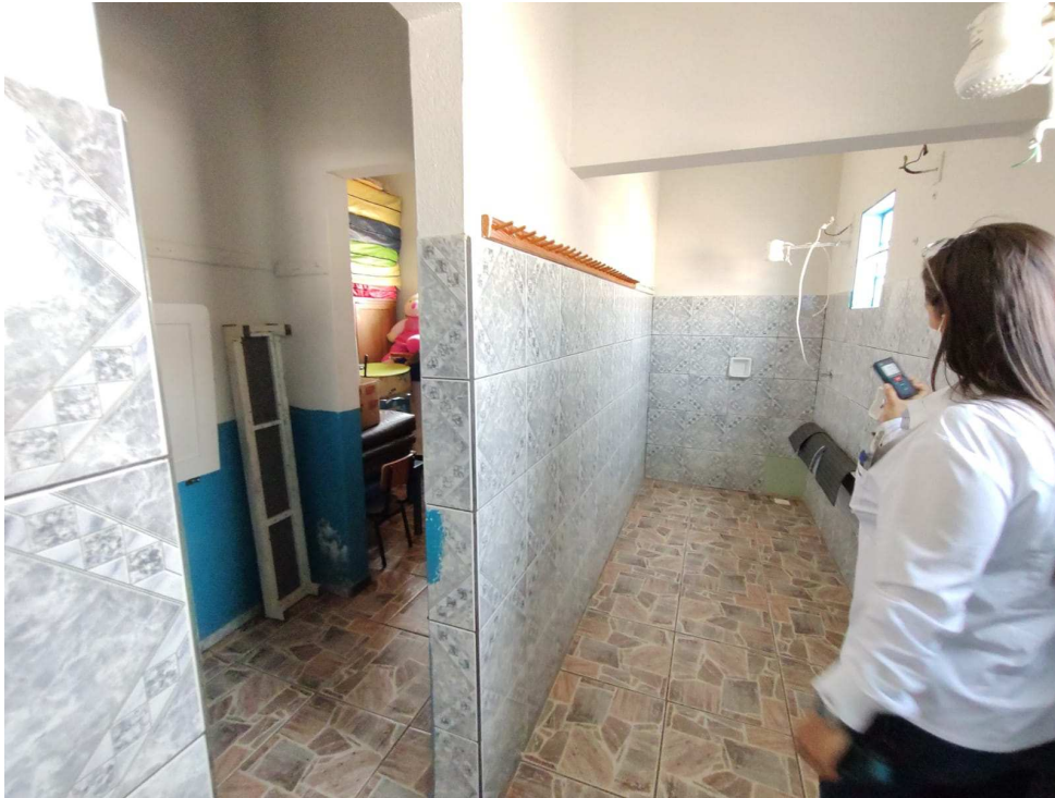
Foto 7 (Banheiro que será substituído o revestimento de parede, e instalado novo piso);
