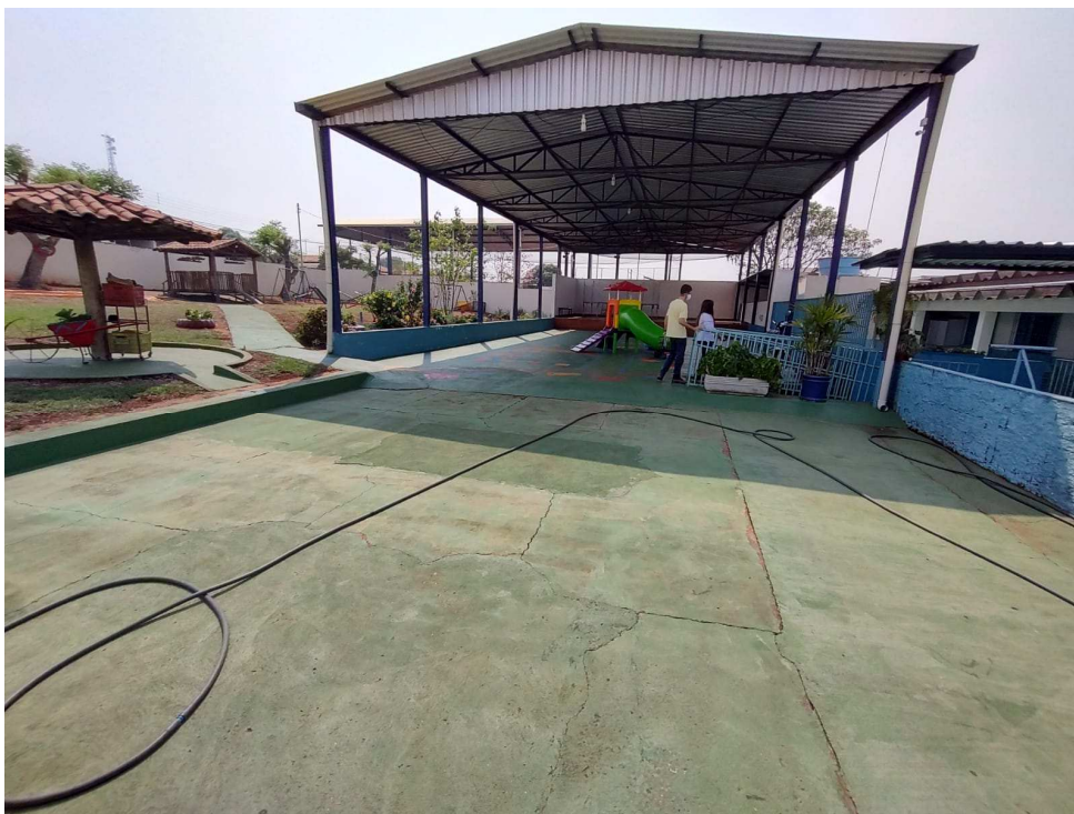
Foto 3 (Cobertura onde será colocada fechamento lateral de telha galvanizada);
