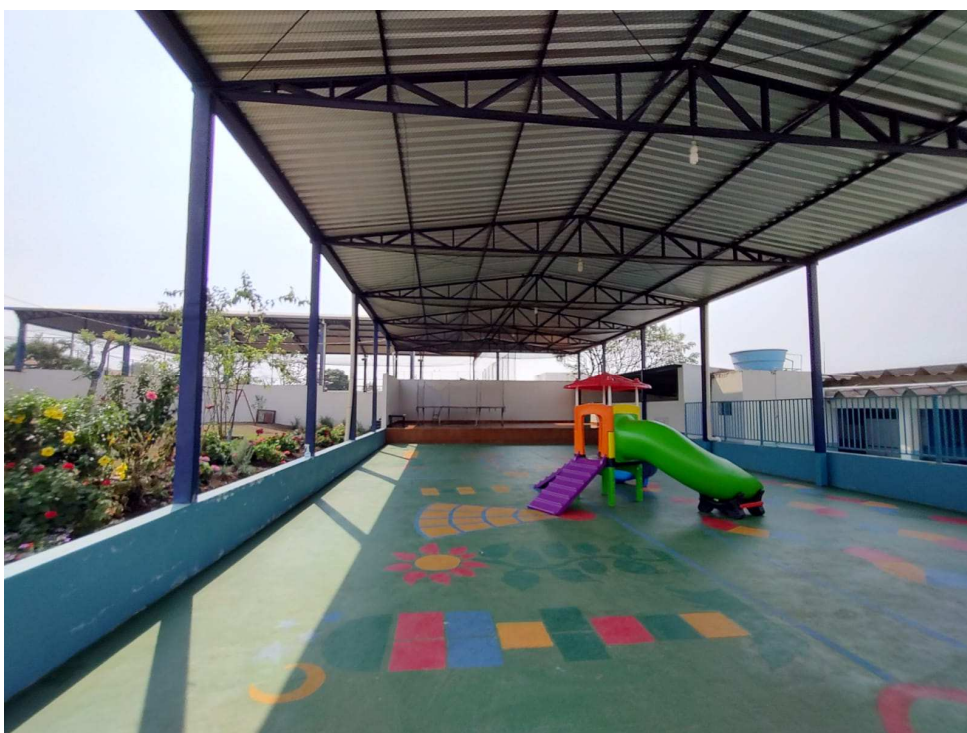
Foto 4 (Cobertura onde será colocada fechamento lateral de telha galvanizada);
