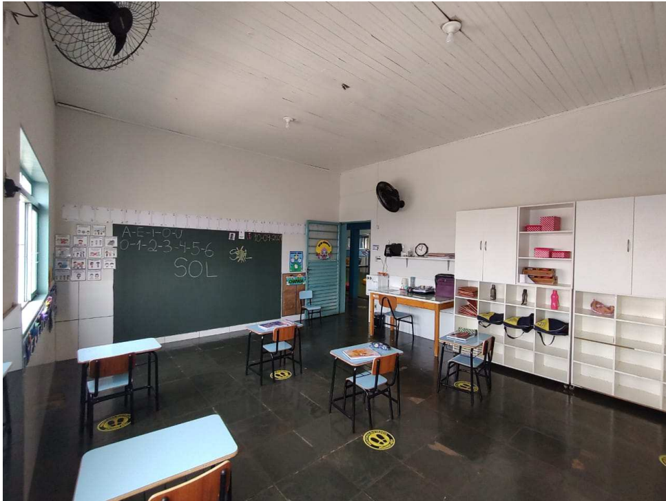
Foto 11 (Sala onde será substituído forro e instalado novo piso);
