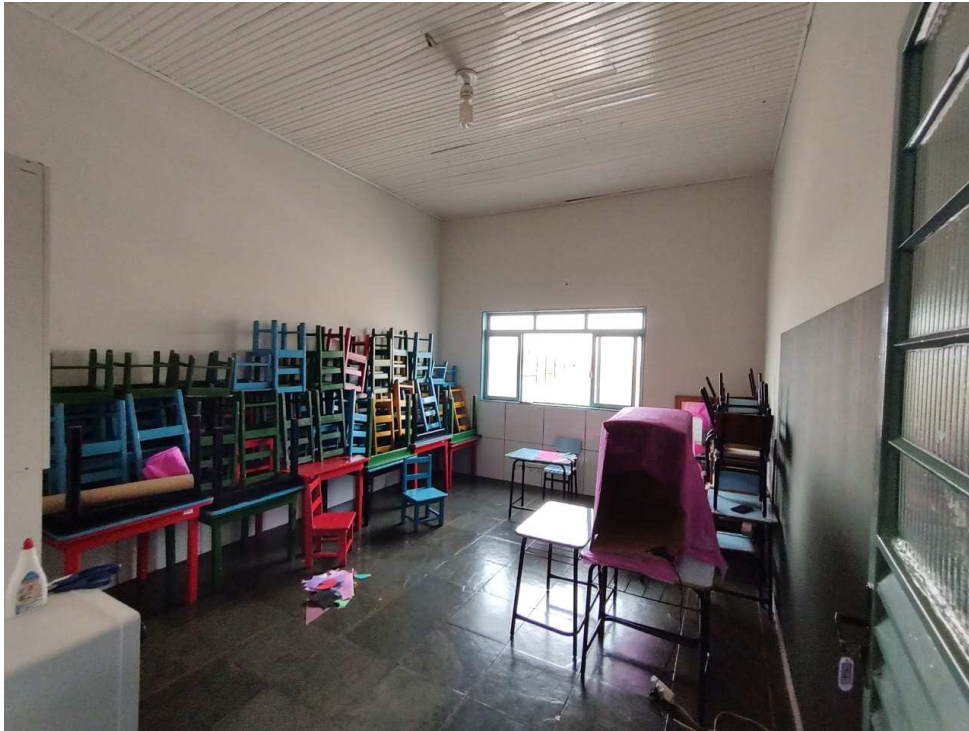
Foto 9 (Sala onde será substituído forro e instalado novo piso);
